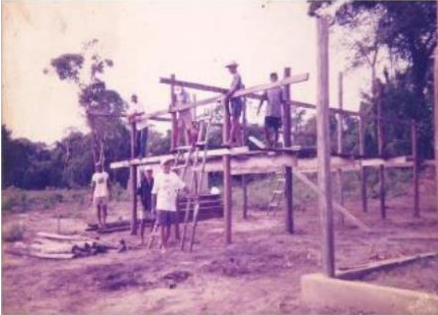
Figura 4. Imagem dos moradores construindo as casas na Vila Nova Jutaf.
